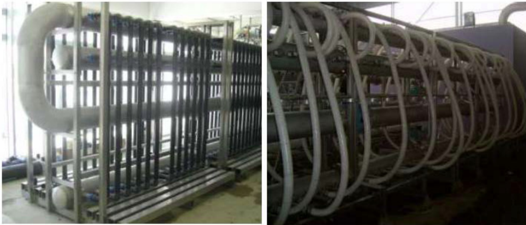
图 1 调试时冲洗阶段的系统软管连接示例
